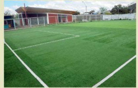
■ La infraestructura deportiva del liceo Hardware es la primera cancha con pasto sintético de la comuna.
