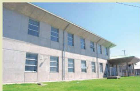
El centro de salud Confraternidad se inauguró oficialmente en 1982. Hoy, después de casi tres décadas la comunidad cuenta con un moderno edificio que atenderá a más de 30 mil inscritos en 2.200 m 2 construidos.
