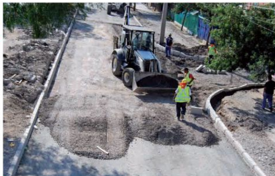
La reparación de esta calle tiene una extensión de 670 metros de longitud.
