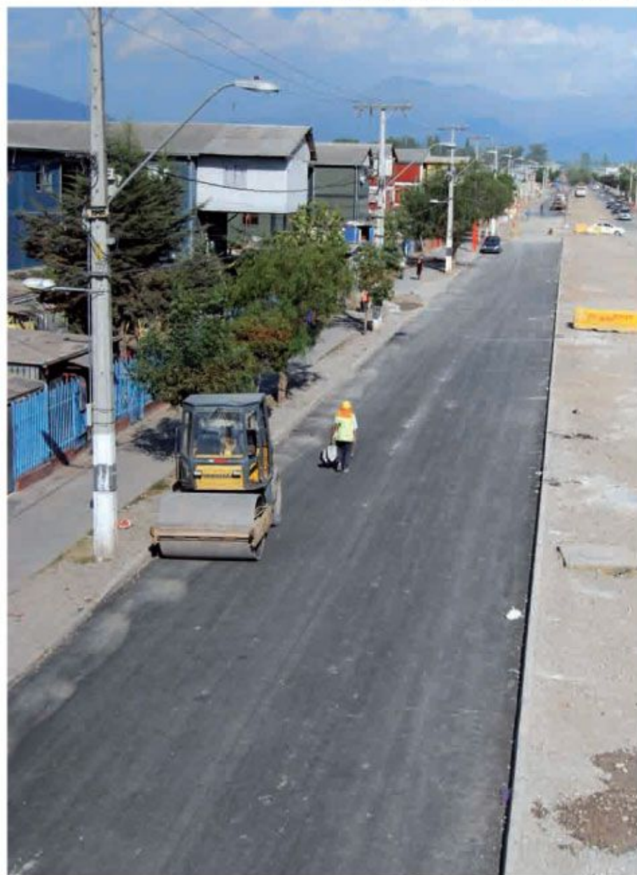
Las obras que se están ejecutando en Balmaceda, serán entregadas a fines de enero.
