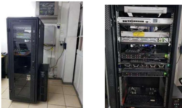
Foto 3. Rack con Servidores (Novuslis y Bioslis), Firewall, y equipo de comunicación internet.
