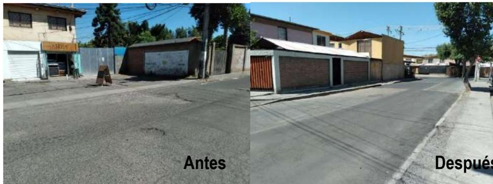
**Intervenciones Provisorias de Emergencia (IPE) – Pavimentos de Hormigón:** Este programa de intervención, financiado en su totalidad con recursos municipales, se implementa cuando se detectan fracturas en las losas de hormigón de la calzada, las cuales pueden comprometer la seguridad vial y aumentar el riesgo de accidentes. Las reparaciones consisten en la remoción y reposición de las losas dañadas, asegurando una superficie estable y resistente para la circulación vehicular y peatonal.
